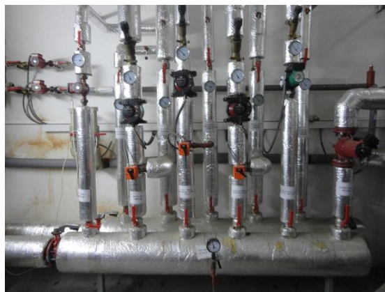
Rozdělovač a sběrač otopné vody
