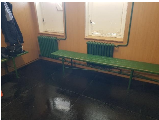
Otopné těleso článkové bez TRV
