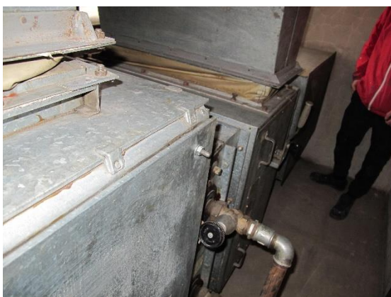
VZT jednotka pro ohřev přívodního vzduchu
