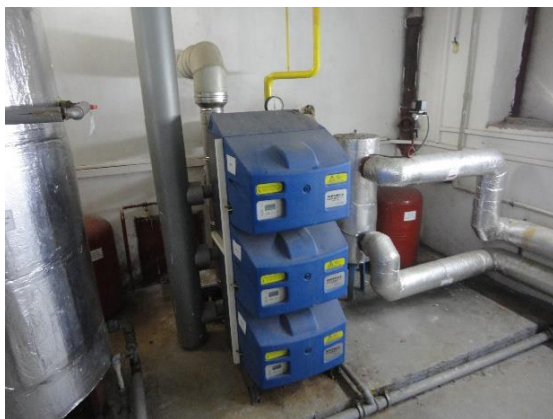
Zdrojem tepla je sestava kotlů na zemní plyn
