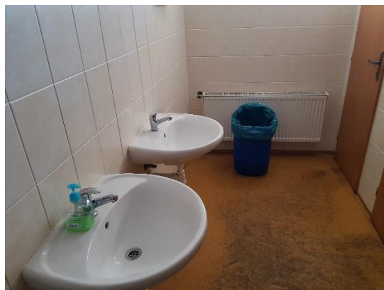
Otopné těleso deskové bez TRV
