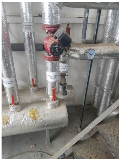
Topná větev pro ohřev TV s oběhovým čerpadlem
