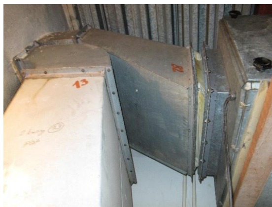
Podstropní VZT jednotka pro ohřev přívodního vzduchu
