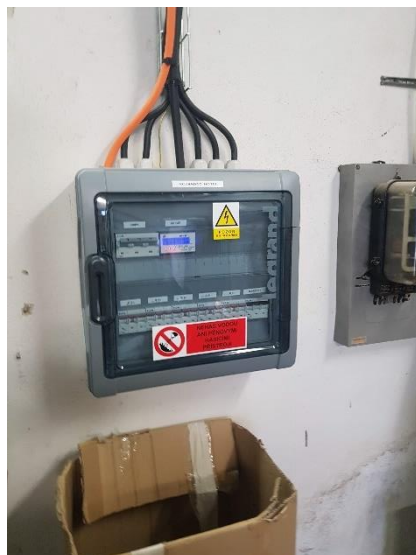
Rozváděč a podružné měření spotřeby elektřiny hotelu
