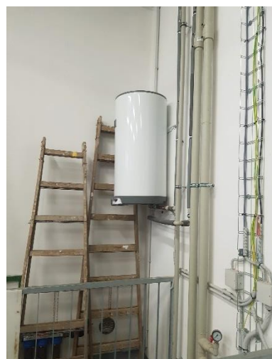
Elektrický boiler v rolbovně – ohřev TV pro obsluhu
