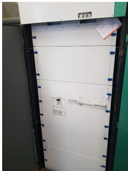
Hlavní jištění před fakturačními elektroměry
