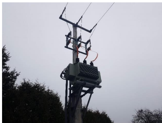
Stožárový transformátor 22/0,4 kv
