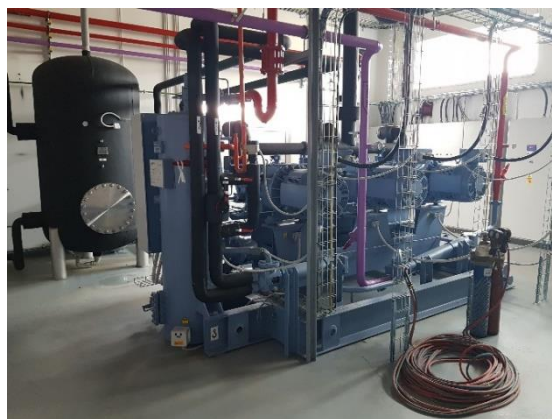
Trojice šroubových kompresorů; v pozadí vlevo zásobník teplé vody pro rolbu
