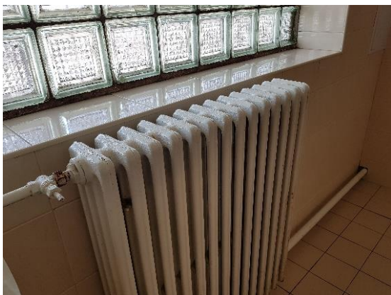
Otopné těleso článkové bez TRV
