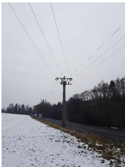
Odbočka VN z nadzemního vedení distributora 22 kV
