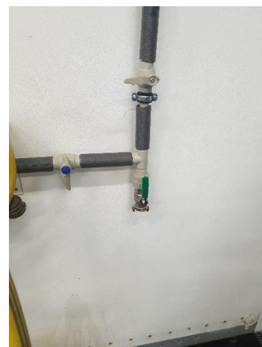
Záložní napouštěcí ventil teplé vody pro rolbu z cirkulačního rozvodu TV
