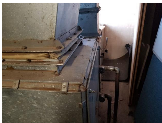
VZT jednotka pro ohřev přívodního vzduchu
