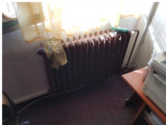
Otopné těleso článkové bez TRV
