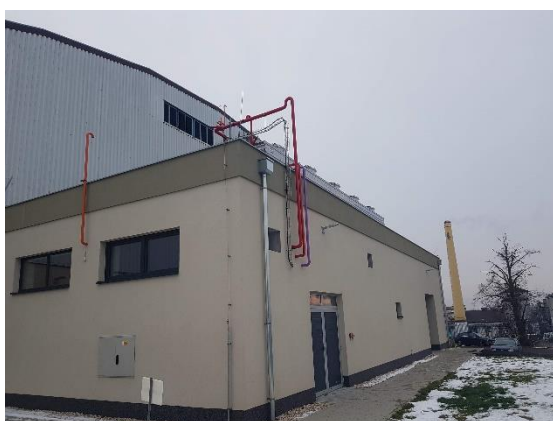
Vzduchový chladič – kondenzátor na střeše strojovny pro odvod přebytečného tepla z chlazení
