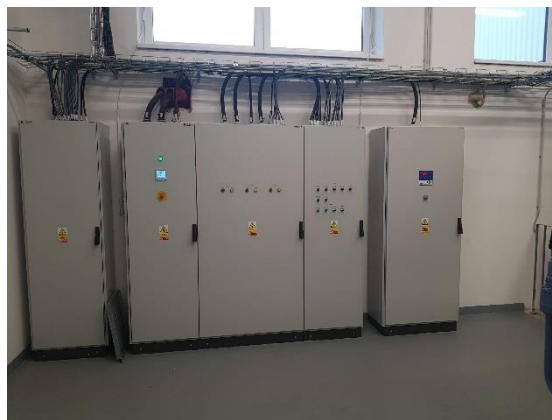
Rozváděč strojovny chlazení vč. regulátoru jalového výkonu, vpravo
