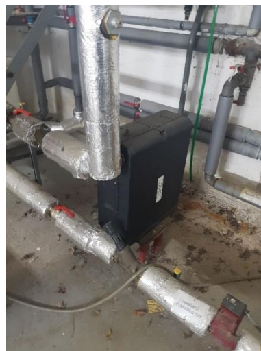
Deskový výměník jako zdroj tepla pro ohřev teplé vody; vpravo dole nabíjecí čerpadlo
