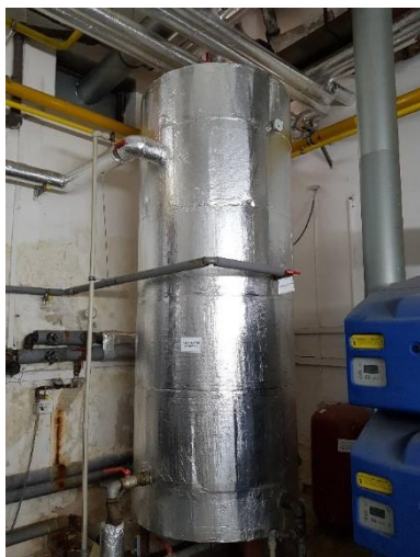
Nepřímoohřevný zásobník teplé vody o objemu 2 500 l v kotelně
