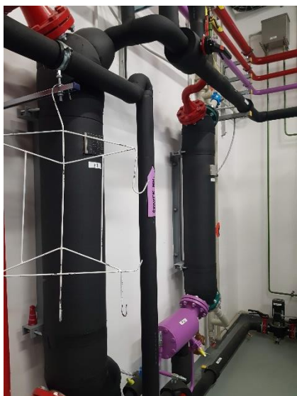
Dvojice trubkových výměníků; v popředí rozmrazování sněhu a ledu ve sněžné jámě, v pozadí ohřev recirkulované vody pro rolbu – úprava ledu
