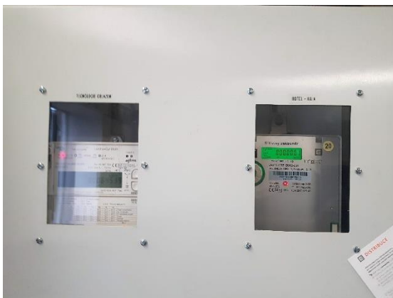
Fakturační elektroměry vlevo technologie chlazení, vpravo ostatní spotřeba
